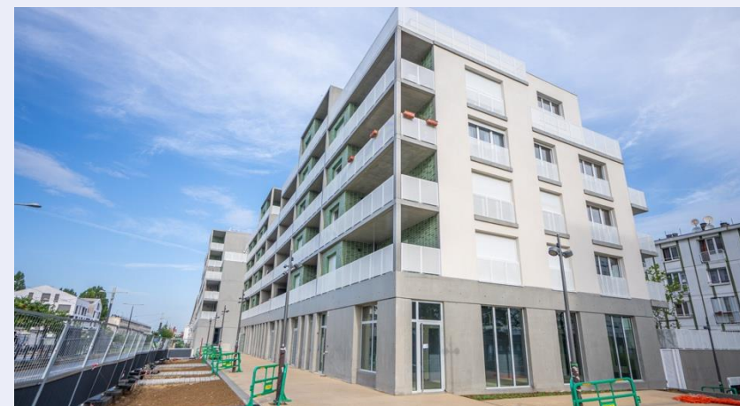
Photo de l'immeuble depuis le parvis des Genettes
