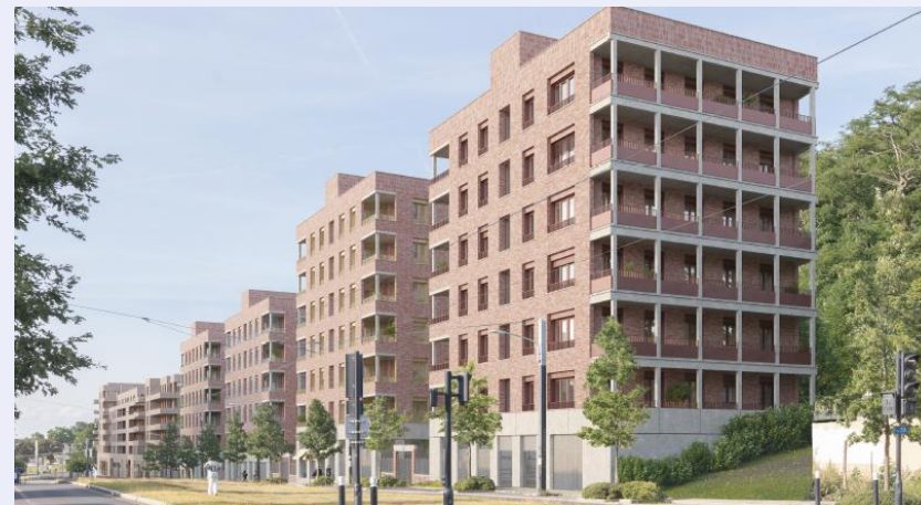
Image du projet depuis l'avenue de l'Avenir
